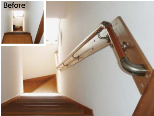
BAUHAUS セレクトシリーズ Color : 手すり棒/Mブラウン(アッシュ丸棒)、木製ベースプレート/Mブラウン、ブラケット/ブラウン Note : 戸建住宅(新潟県) 階段を降り始める箇所の手すりには、水平部分を200mm以上設けるのが望ましいとされています。
