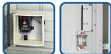
①クエイクセンサー ②解錠装置
